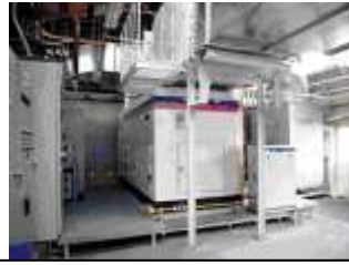
図2. コージェネレーションシステム
