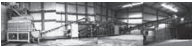
浄水発生土再資源化プラント
