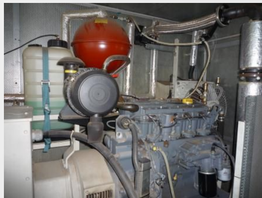
ガスエンジン
