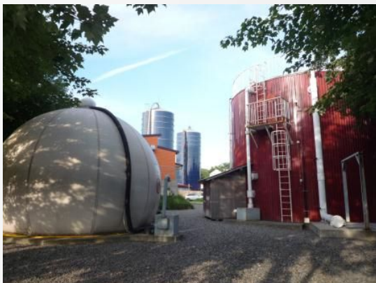
畜ふんバイオガスプラント外観
